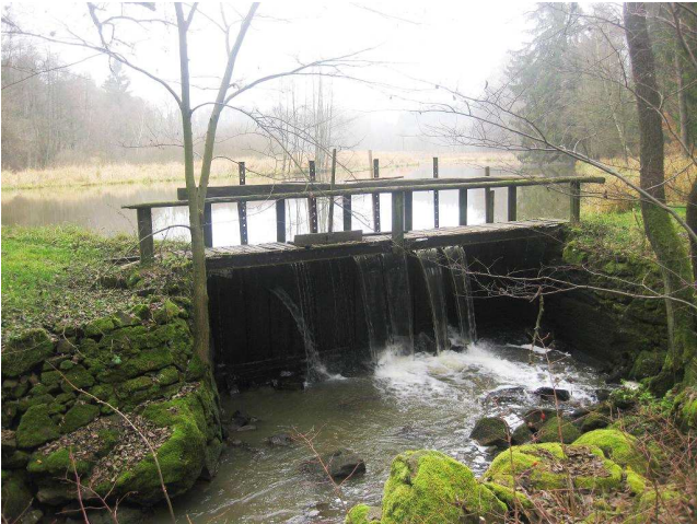
Pohled na vypouštěcí zařízení rybníka
