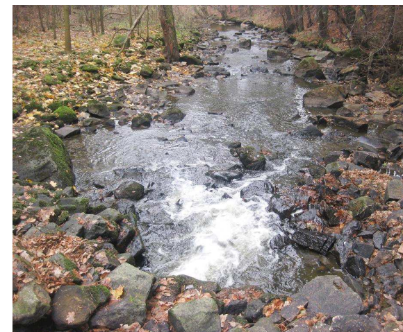
Vyústění trouby zajišťující MZP
