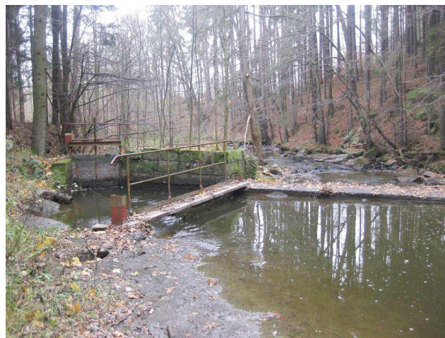
Ústí do náhonu na elektrárnu
