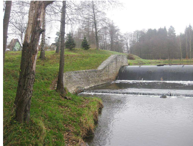
Pohled na pravý břeh z podjezí
