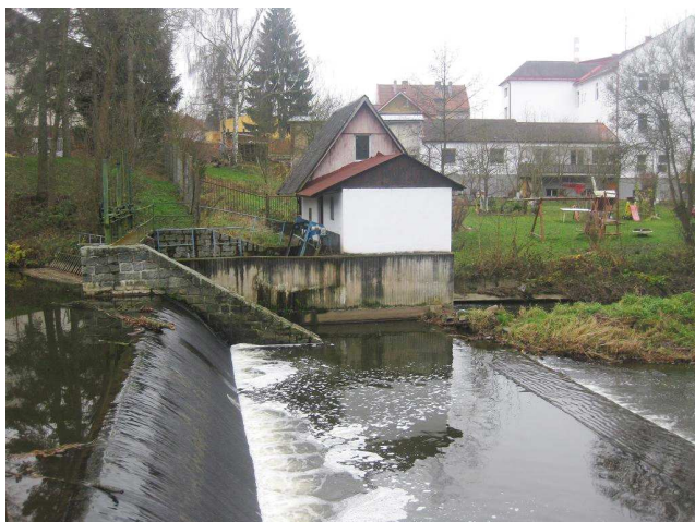
Pohled na jez s MVE
