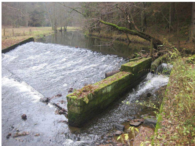
Celkový pohled na jez
