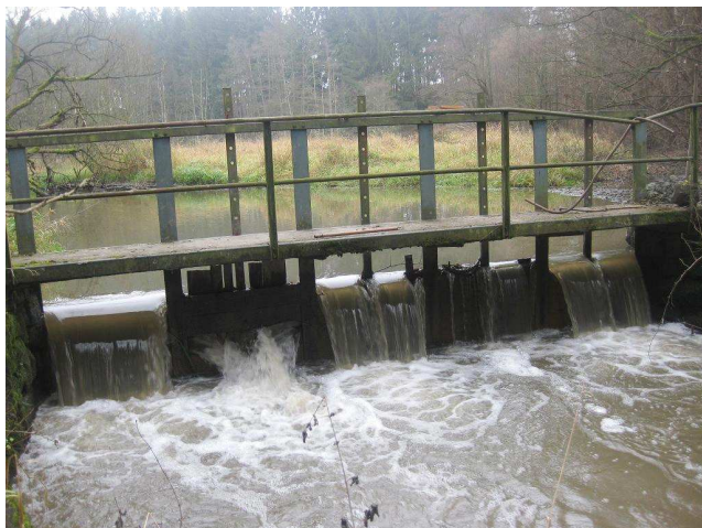
Pohled na stavidlo
