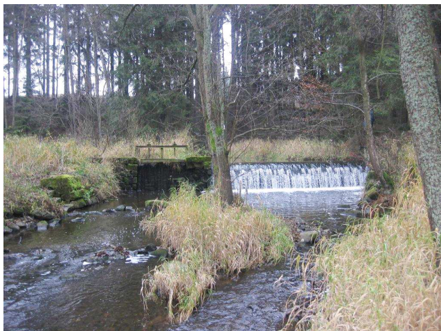
Pohled na jez s jalovou propustí
