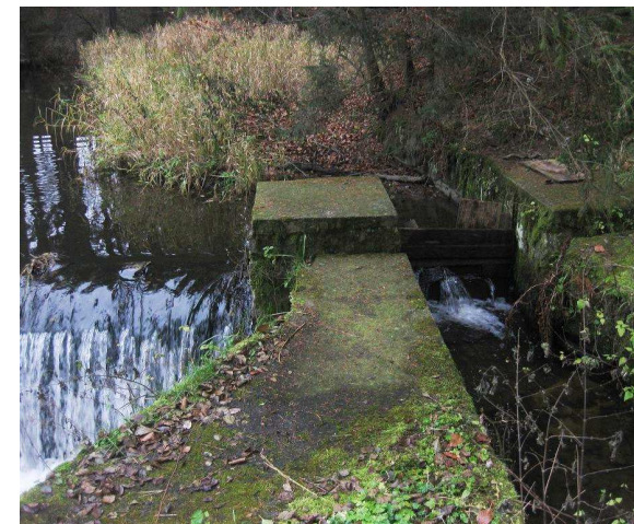
Vstup do napájecího náhonu
