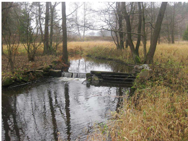
Pohled na stavidlo
