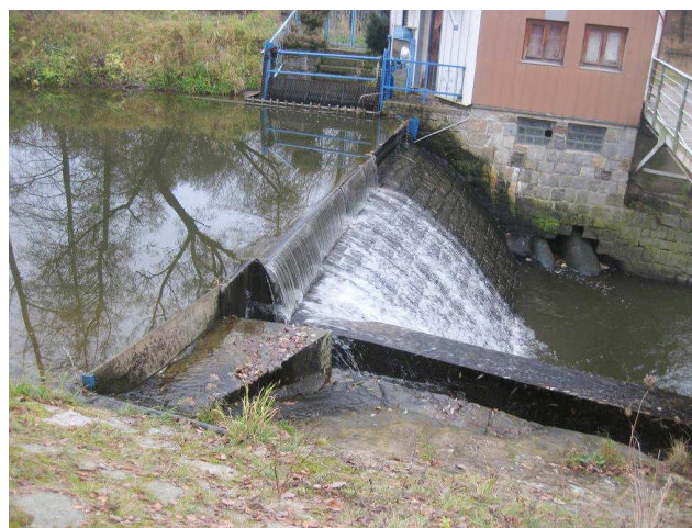
Jez s objektem MVE, v popředí RP
