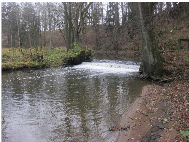
Celkový pohled na jez
