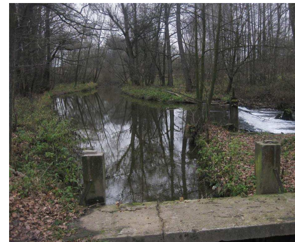
Nadjezí a vstup do náhonu
