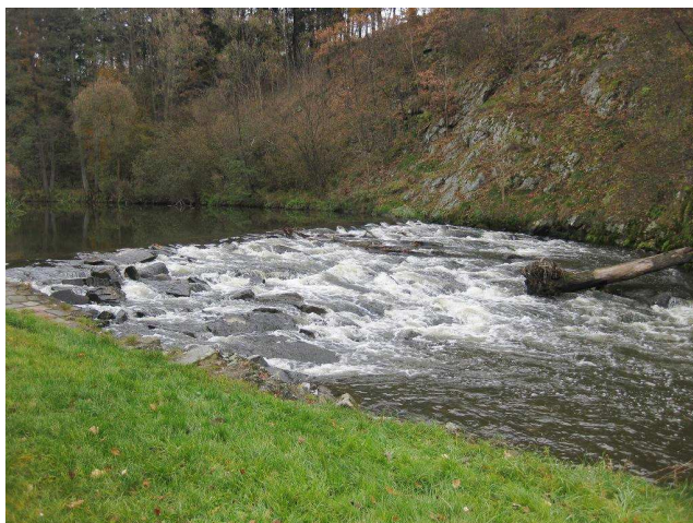
Pohled na jez
