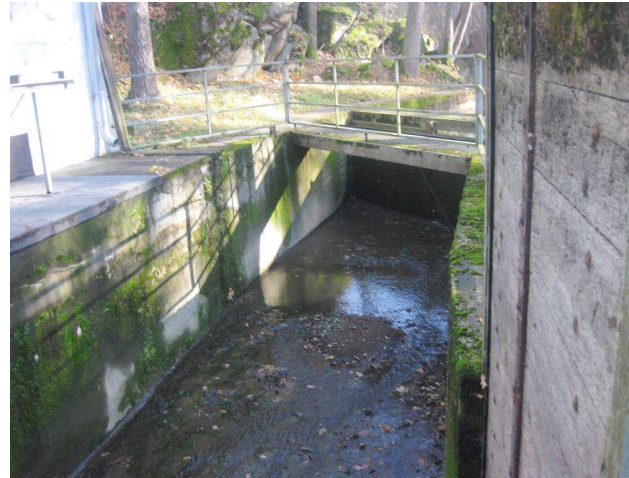
Odpadní kanál z bývalé MVE
