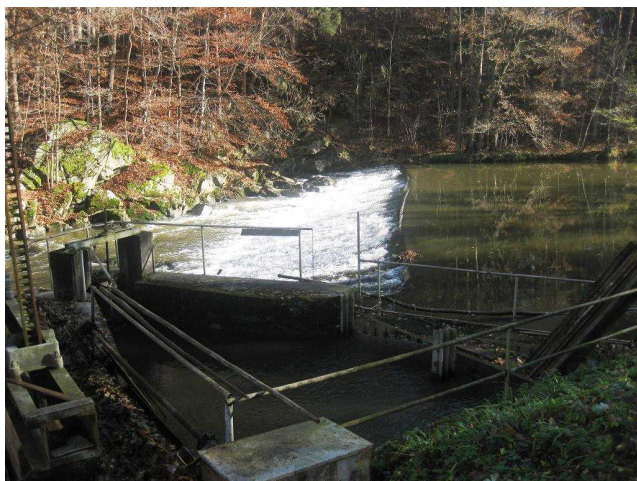
Celkový pohled na jez
