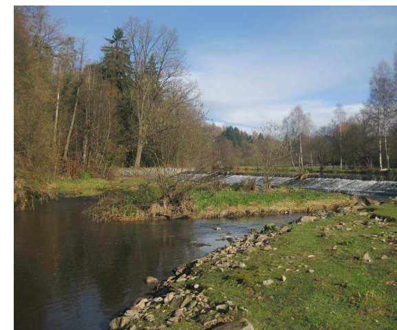
Podjezí se zapojenými nánosy
