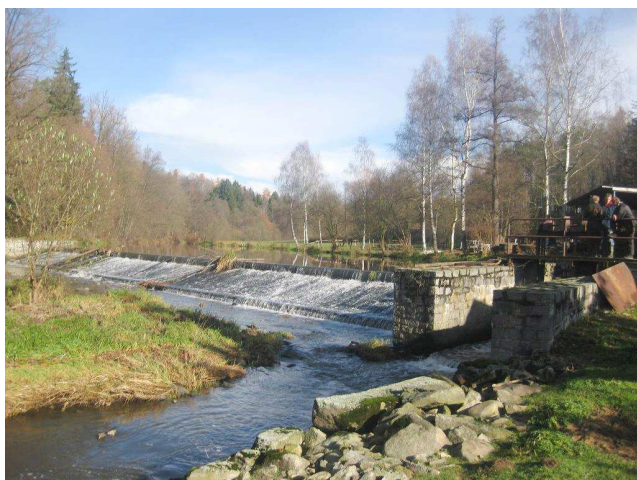
Celkový pohled na jez
