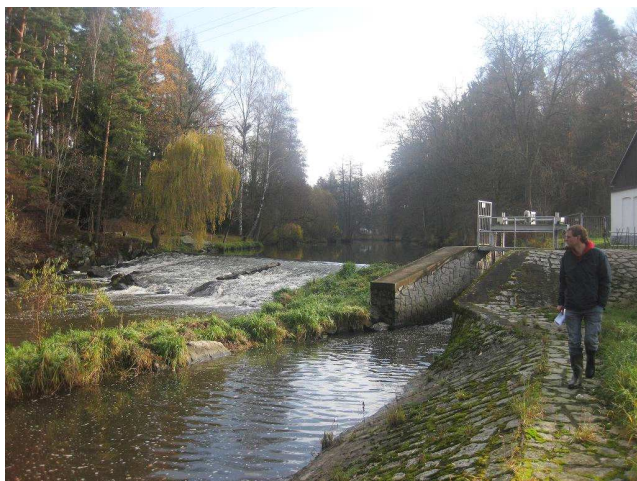
Celkový pohled na jez, v levé části proplachovací propust
