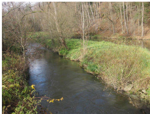
Odpadní kanál z MVE
