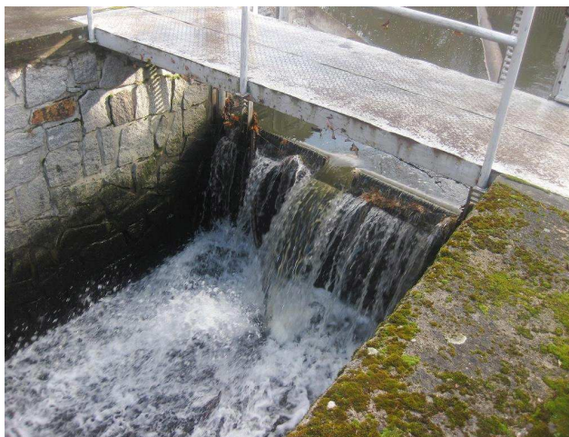
Proplachovací propust
