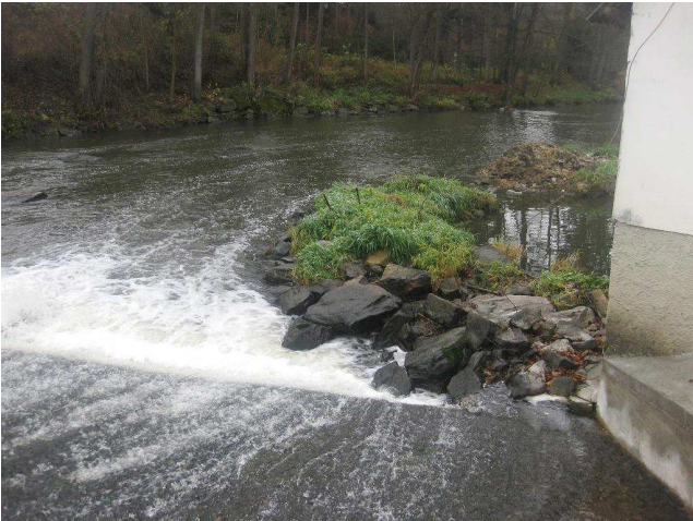
Pravá strana jezu u MVE s dočasnou jímkou
