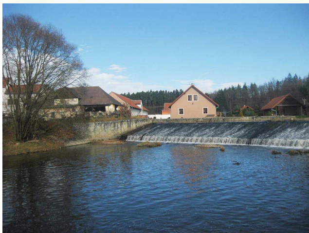
Pohled na pravou část jezu
