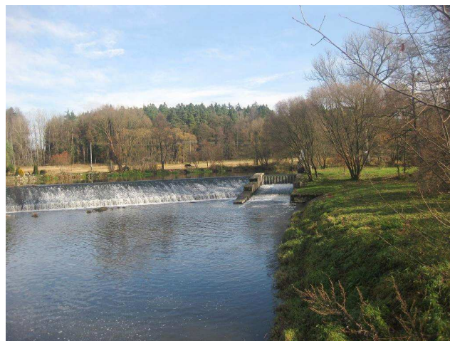
Pohled na levou část jezu s propustí
