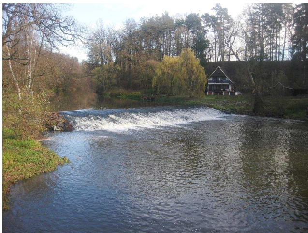
Celkový pohled na jez
