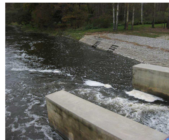
Pohled na pravý břeh a konec propusti
