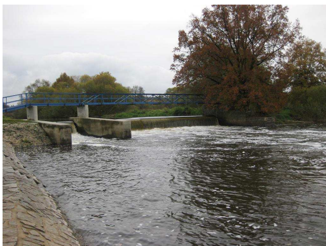
Pohled na pravou stranu jezu a propust
