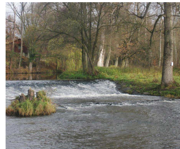
Detail levé strany jezu
