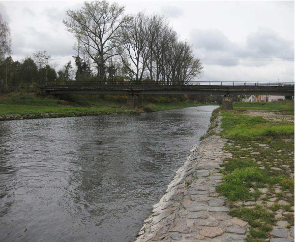
Charakter toku pod jezem s břehovým opevněním
