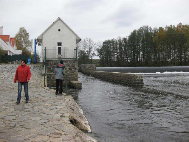
Pohled na objekt MVE a propust
