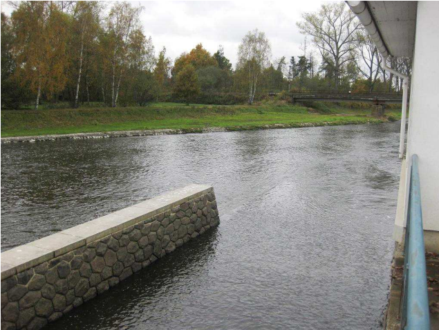
konec opěrné zdi mezi jezem a propustí
