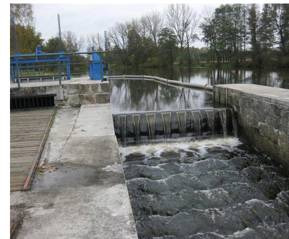
Vorová propust s osazenou klapkou
