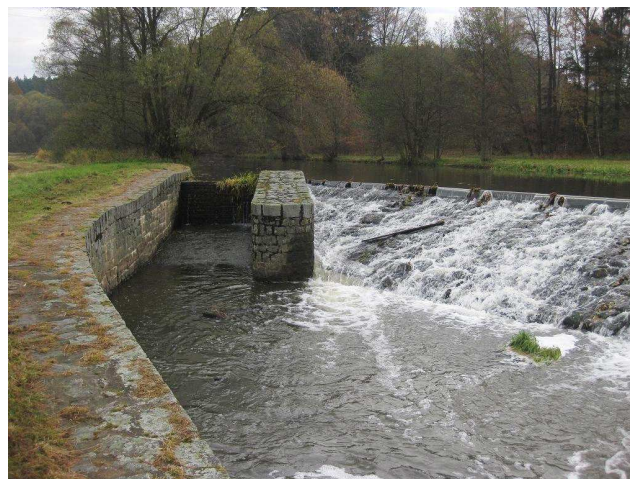
Pohled na proplachovací propust
