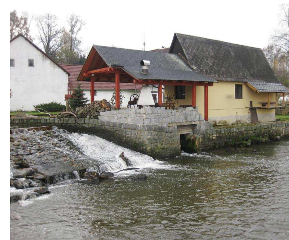
Levý břeh s MVE
