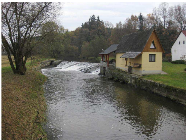
Pohled na jez s objektem MVE a propustí
