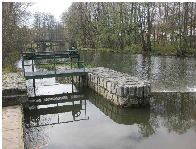
Proplachovací propust na jezu
