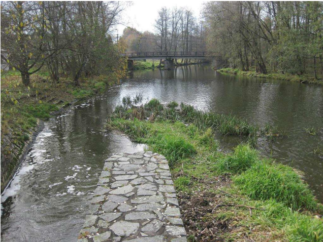
Pilíř mezi jezem a propustí
