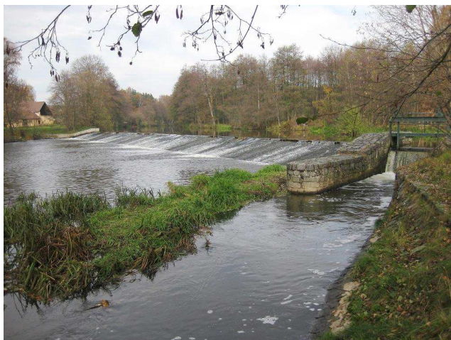
Celkový pohled na jez
