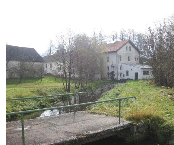
Náhon a objekt MVE
