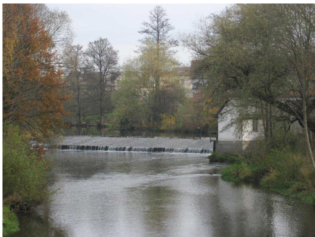
Pohled na jez ze silničního mostu
