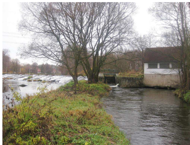
Odpadní kanál a objekt MVE
