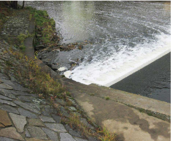
Opevnění levého břehu
