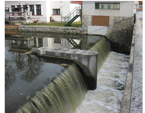
Detail jezové hrany a silničního mostu
