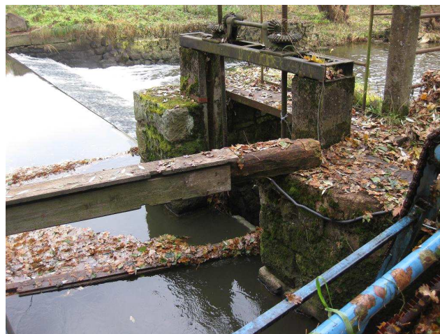
Proplachovací propust u nátoku do MVE
