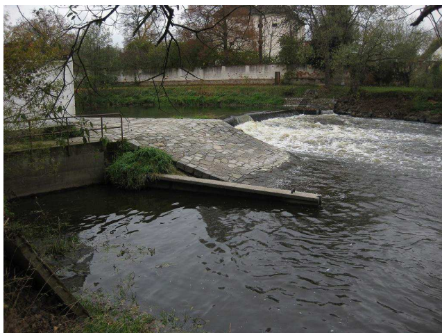
Celkový pohled na jez
