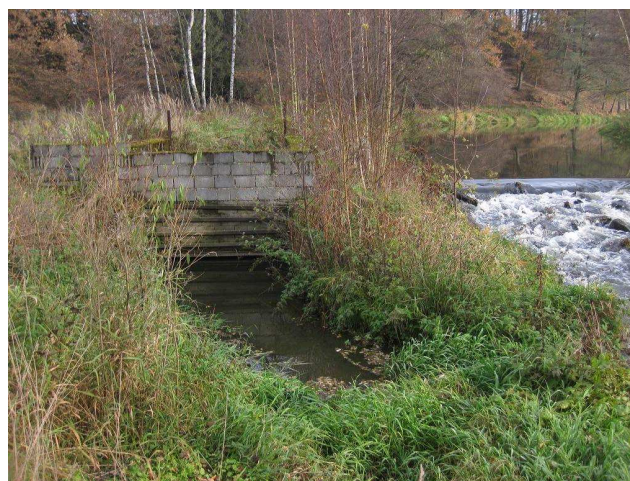
Pohled na rozestavěnou MVE
