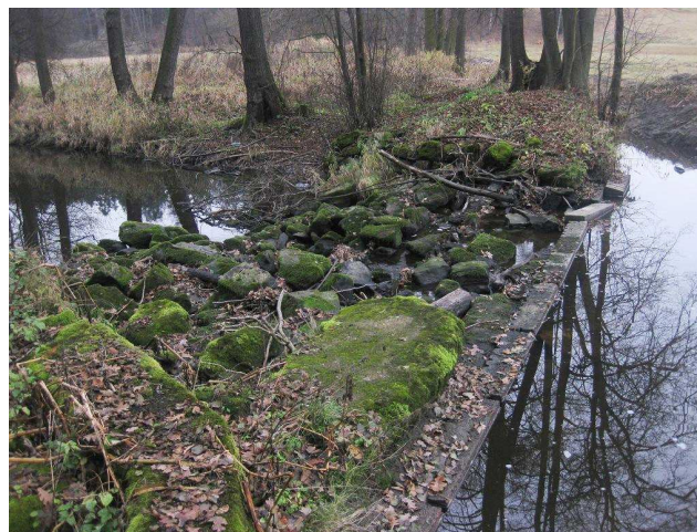
Pravá část jezu
