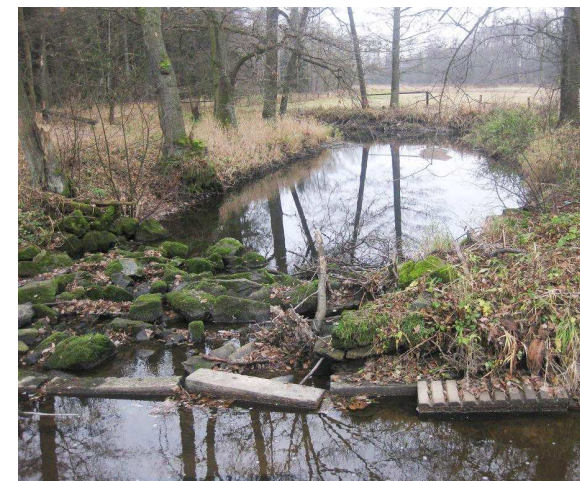
Pravá část jezu
