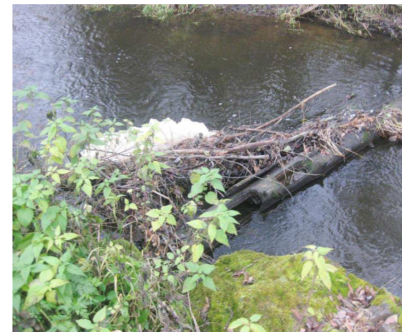
Zbytky původní konstrukce jezu
