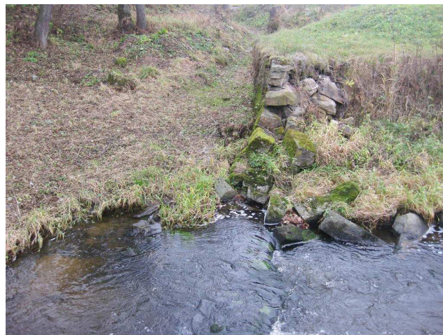
Detail zbytku konstrukce jezu a začátku náhonu
