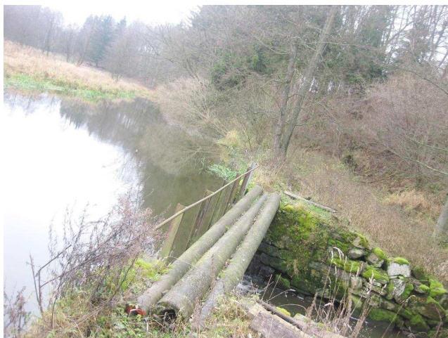
Pohled do nadjezí a jez s provizorní lávkou
