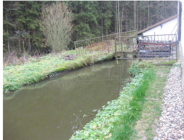
Náhon s objektem vtoku do MVE
