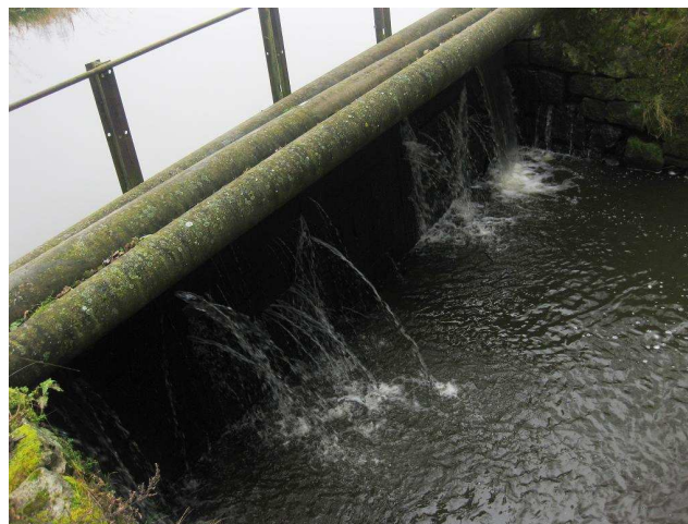
Stavidlo s lávkou
