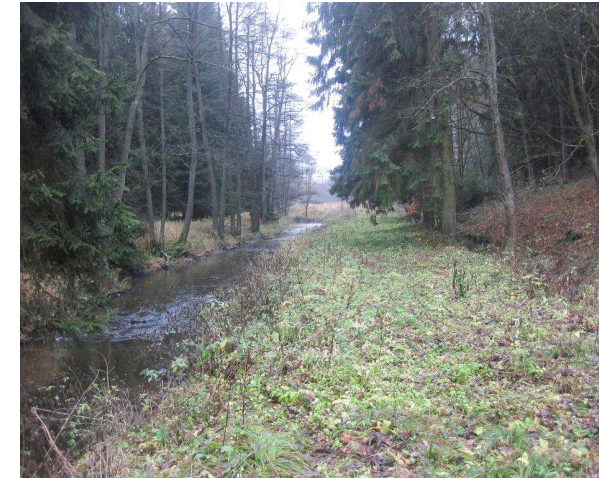
Odpadní kanál od MVE
