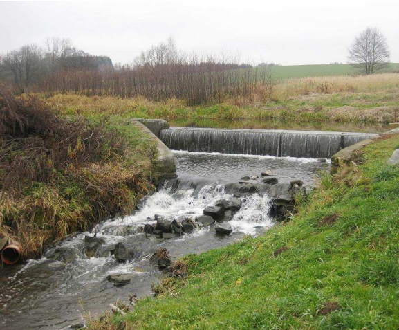
Pohled na jez
