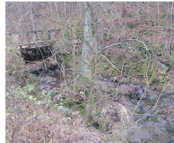
Vrchní část bezpečnostního přelivu
