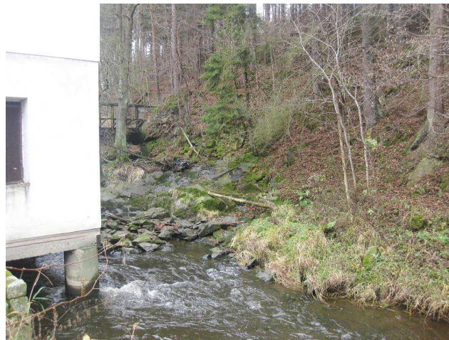
Pohled na bezpečnostní přeliv odspodu
